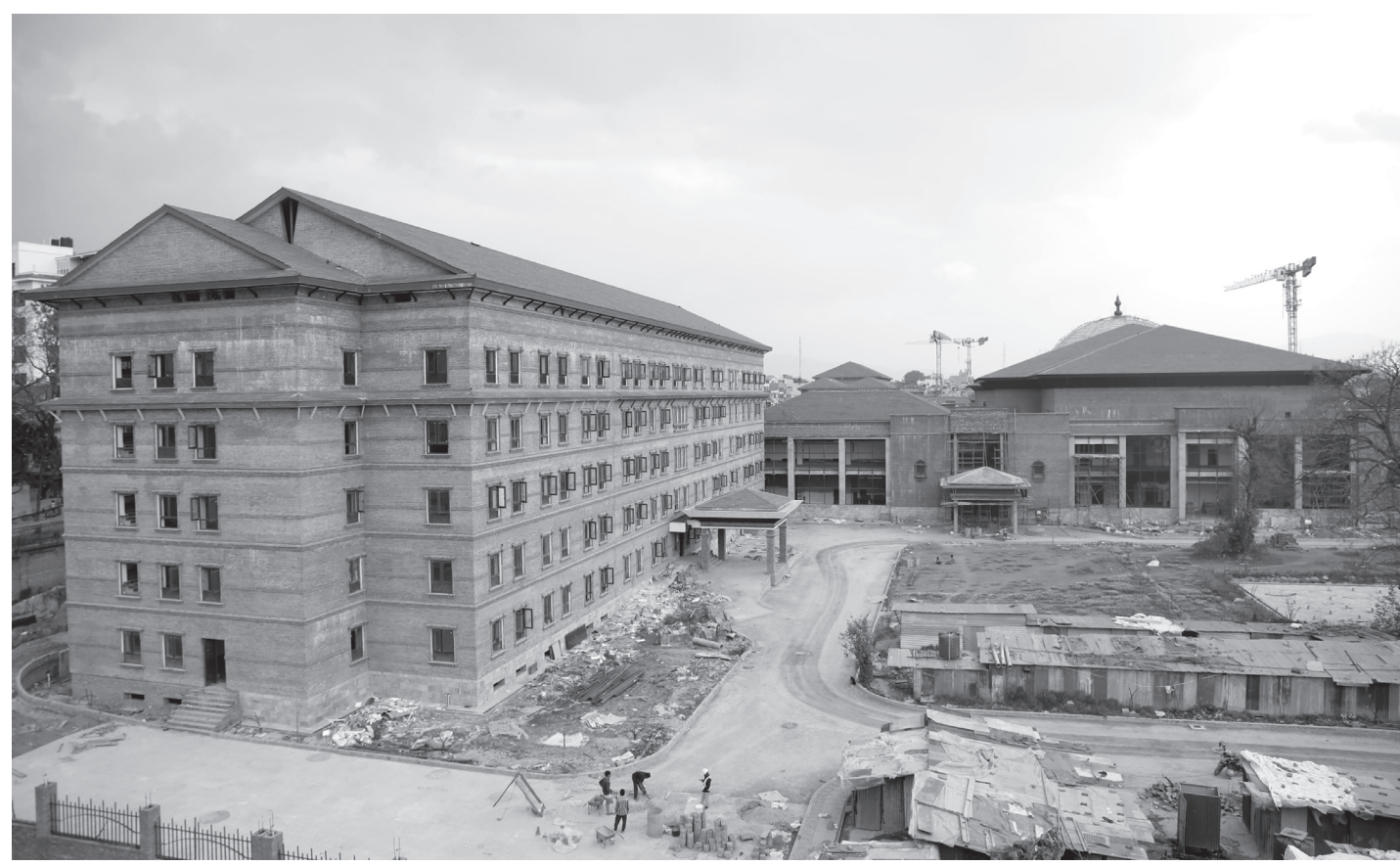
निर्माणाधीन सङ्घीय संसद् भवन
