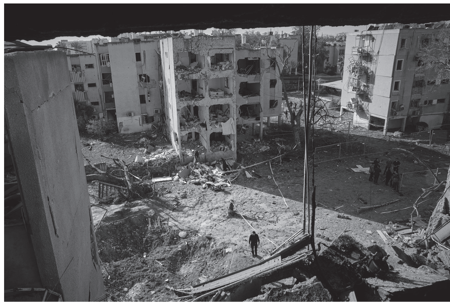
दक्षिणी इजरायलको इराद नगरमा इजरायलका परमाणु परियोजनालाई लक्ष्य गरी इरानले गरेको मिसाइल हमलामा परी क्षतिग्रस्त भएका परियोजना परिसरका आवासीय भवनहरू मार्च २२, २०२६ का दिन। तस्बिर: एपी/ओहाद जिवगेन्वर्ग
