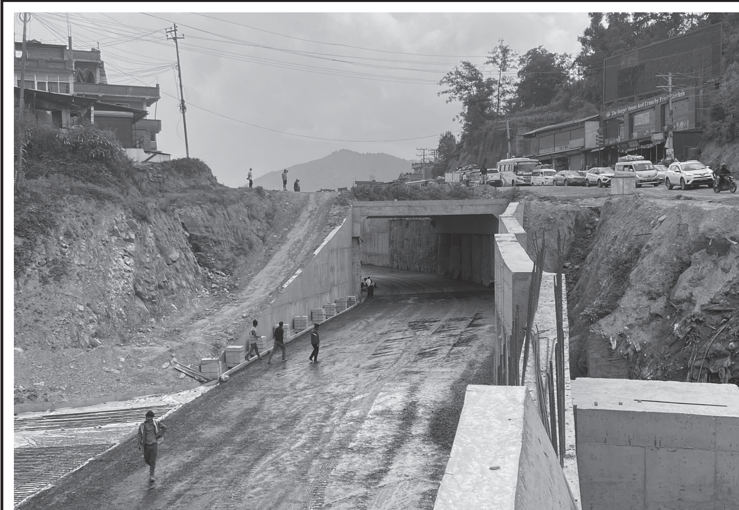
साँगामा निर्माणाधीन ‘अन्डरपास’
