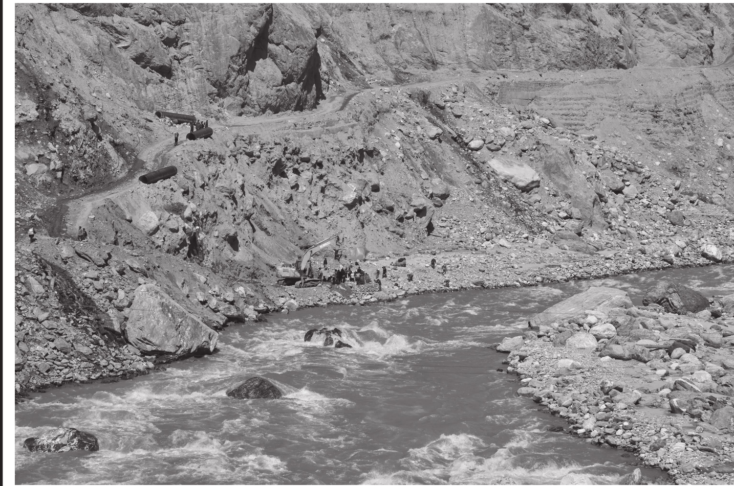
चिलिमे जलविद्युत् आयोजना क्षेत्रमा सडक निर्माण कार्य भोटेकोसी नदीमा आएको बाढीले क्षति पुऱ्याएपछि चिलिमे जलविद्युत् आयोजनाको प्रवेशद्वार तथा बाढी प्रभावित क्षेत्रमा भइरहेको सडक निर्माण कार्य । तस्विर : प्रदीपराज वन्त/रासस
